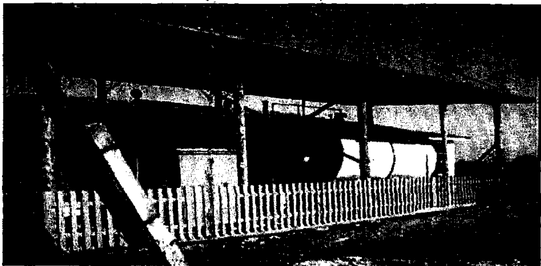
Рис. 4.8. Биореактор-метатенк и газгольдер теплоэлектростанции АБЭУ 20 с установленной электрической мощностью - 3,3. кВт и тепловой - 7,1 кВт ( пос. Горелое Тамбовской области)
