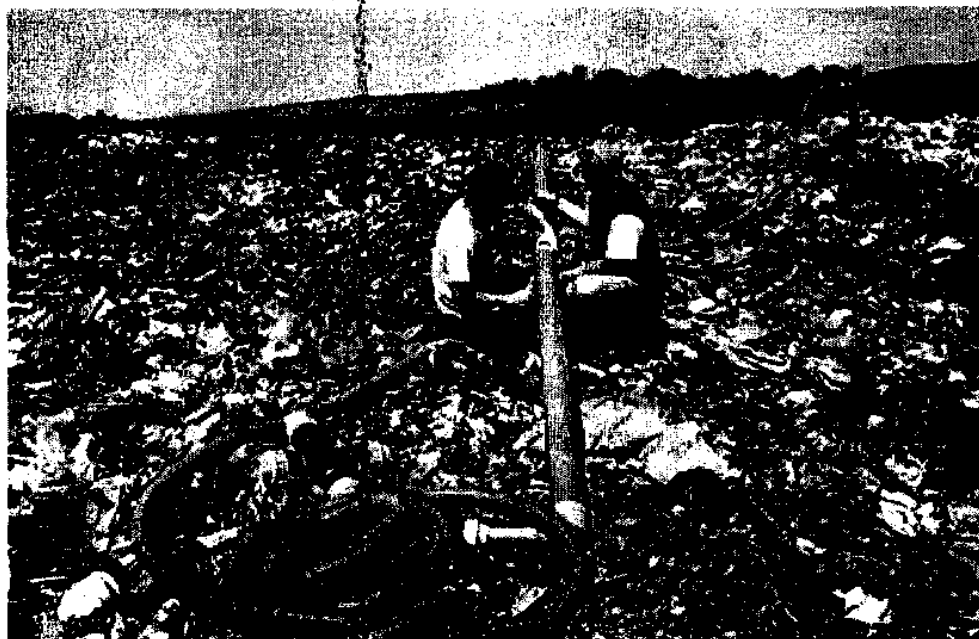
Рис. 4.6. Монтаж системы сбора биогаза.
